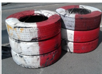
Figur 7.49 Eksempler på dæksøjler som er forsvarligt sammenkoblede.
