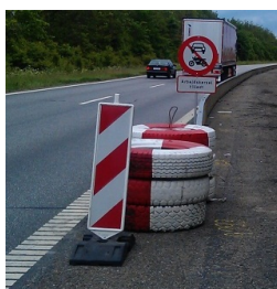
Figur 7.49 Eksempler på dæksøjler som er forsvarligt sammenkoblede.
