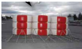
Figur 7.51 Eksempel på tværafspærring med sammenkoblede dæksøjler med kædematte.
